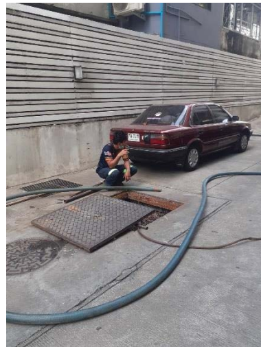
การสูบน้ำและไขมันครั้งล่าสุด ปี 2565 ภาพที่ 2.2-4 (ต่อ) การจัดการน้ำเสียและสิ่งปฏิกูล
