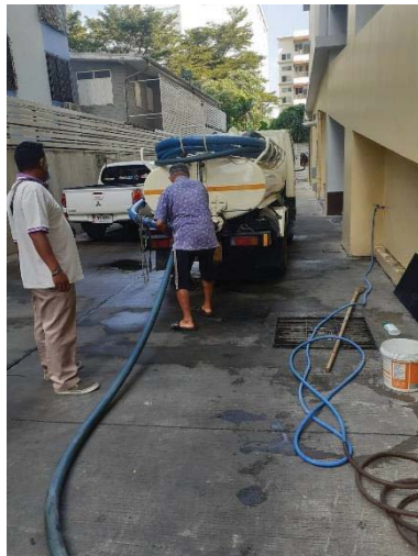
การสูบน้ำและไขมันครั้งล่าสุด ปี 2565 ภาพที่ 2.2-4 (ต่อ) การจัดการน้ำเสียและสิ่งปฏิกูล
